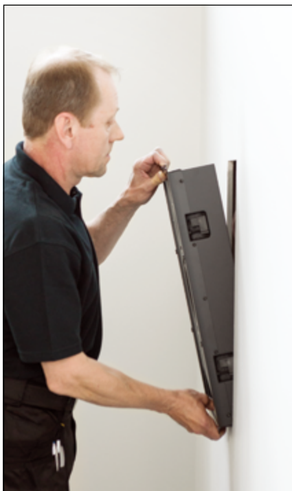
図 2. AIW26B エンクロージャーを穴にはめ込む
