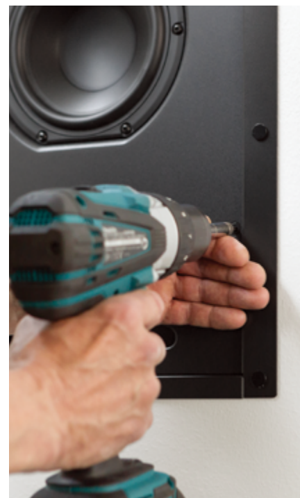
図 5. 4 つのトルクス T25 ネジを 1.5 Nm で締める
