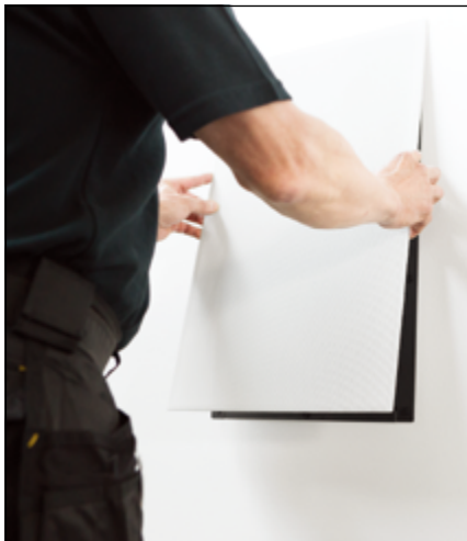
図 6. 金属製グリルをマグネットで固定
